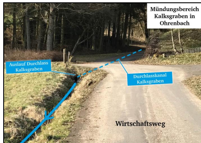
Abbildung 23: Mündungsbereich Durchlasskanal Kalksgraben in Ohrenbach Graben
