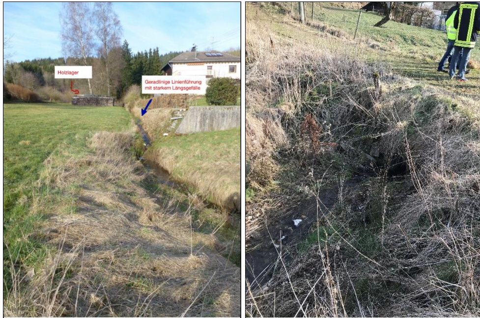
Abbildung 24: Bachverlauf Ohrenbach samt Mündungsbereich Durchlassverrohrung DN 700
