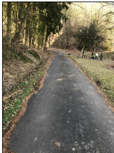
Abbildung 37: Entwässerungsgraben Wirtschaftsweg / "Auf der Ley"
