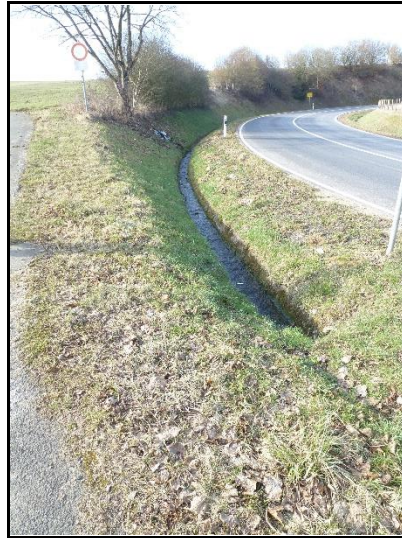
Abbildung 29: Entwässerungsgraben L27 kurz vor Ortseingang. Blickrichtung nach Norden.
