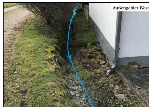
Abbildung 21: Graben hinter des Durchlasses unmittelbar vor Einlaufbauwerk
