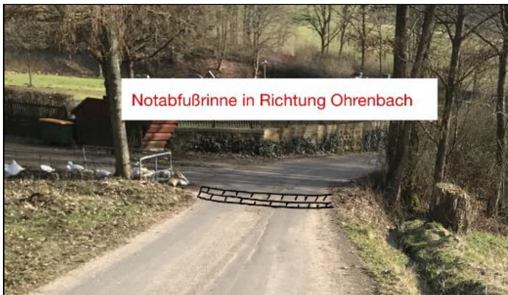
Abbildung 55: Notabflussrinne in Richtung Ohrenbach
