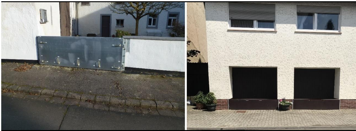
Abbildung 51: Objektschutzmaßnahmen “Im Überecken“ 17, Dorfstraße 48
