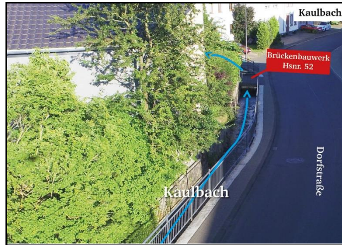
Abbildung 10: Paralleler Verlauf des Kaulbach, zur Dorfstraße im verbauten Gerinne
