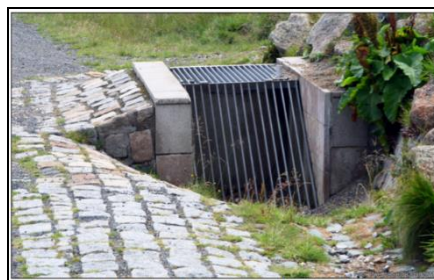
Abbildung 54: Beispiel eines Einlaufbauwerks mit Rechen (Halbach, 2012)
