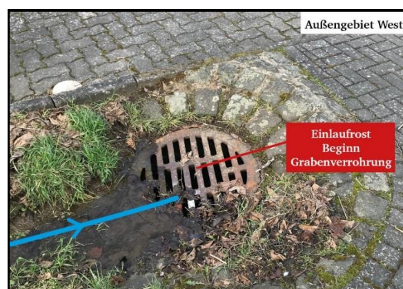
Abbildung 22: Einlaufbauwerk Grabenverrohrung
