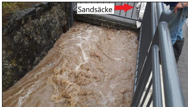
Abbildung 62: Absicherung der Brücke Dorfstraße durch Sandsäcke am 01.06.2018
