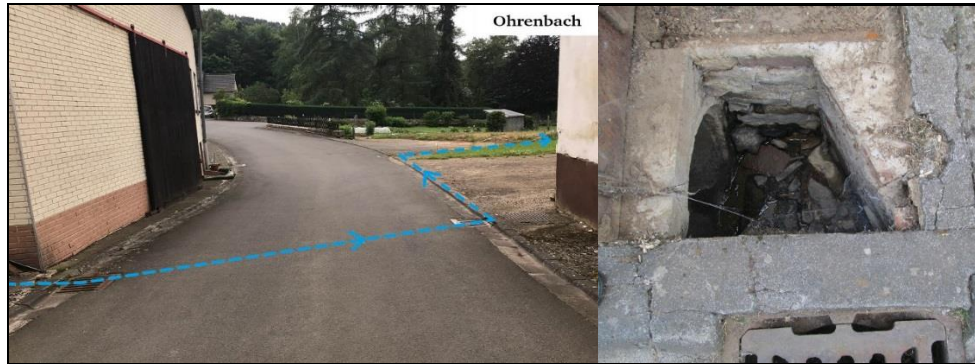
Abbildung 43: Linienführung Bachverrohrung mit 90 Grad Bogen
