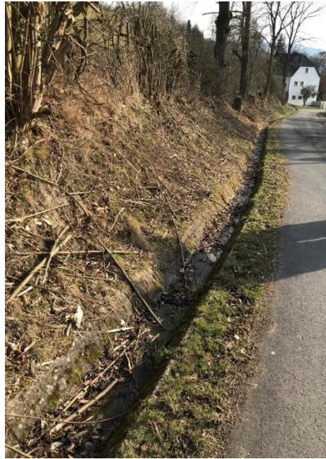
Abbildung 39: Betonhalbschalen entlang Gemeindestr. „Im Ohrenpesch“
