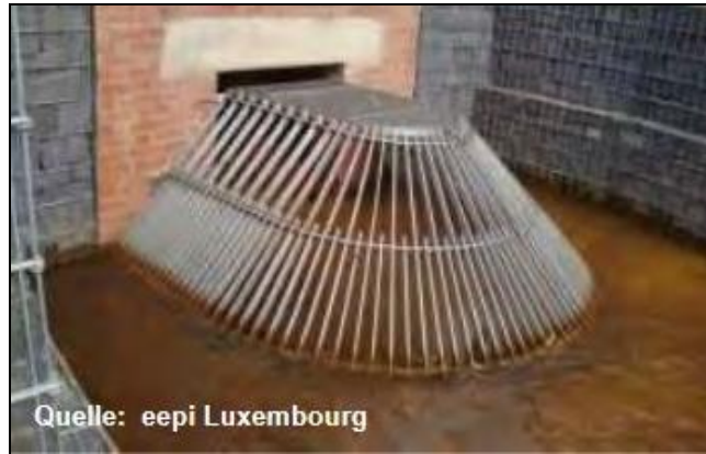
Abbildung 57: Beispielbild 3D Rechen samt Geröllfang (Ingenieurbüro eepi Luxembourg Sàrl, Michael Buschlinger, 2015)
