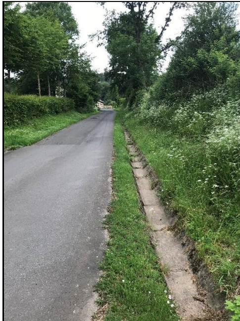
Abbildung 38: Betonhalbschalen entlang der Gemeindestr. "Im Ohrenpesch"
