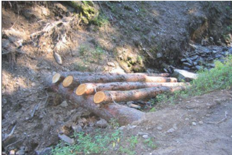
Abbildung 56: Beispiel einfacher Totholz u. Treibgutrechen (Informations- und Beratungszentrum Hochwasservorsorge Rheinland-Pfalz, WBW Fortbildungsgesellschaft für Gewässerentwicklung mbH, 2013, S. 35)
