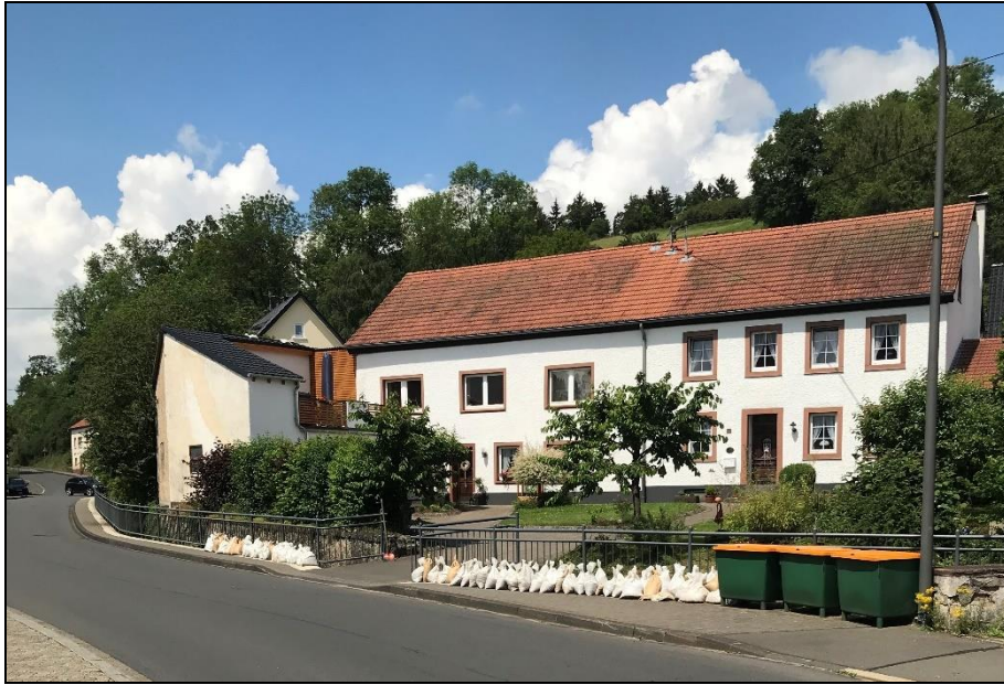
Abbildung 61: Sandsack Lagerbehältnisse vor Dorfstraße Hsnr. 52
