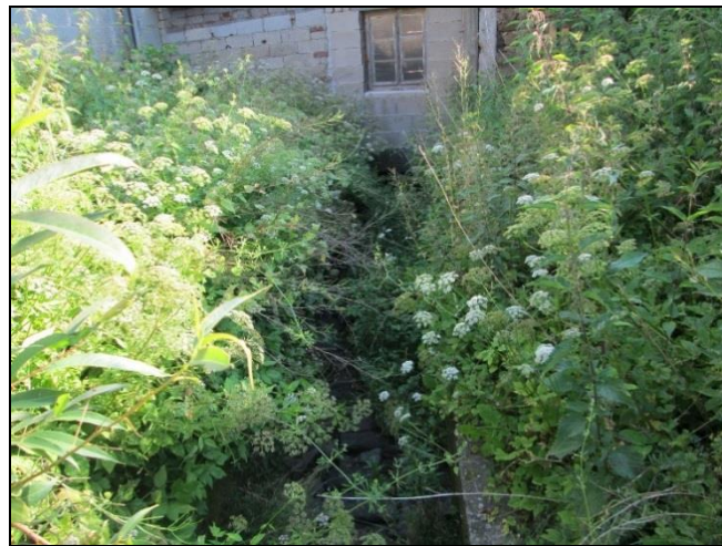
Abbildung 44: Einlaufbereich Bachverrohrung im Sommer 2018
