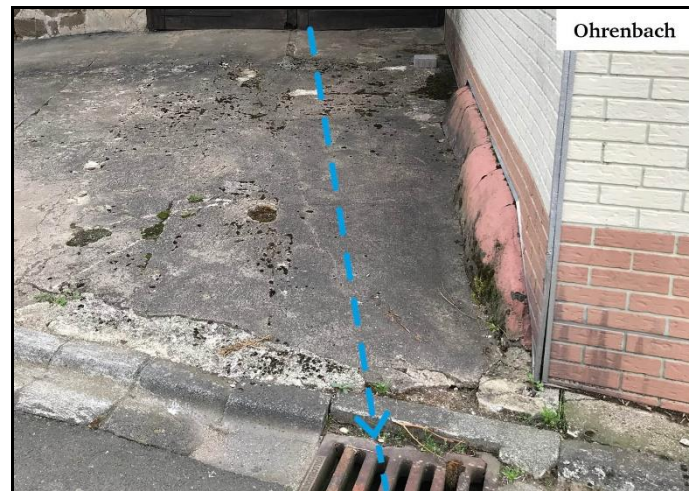
Abbildung 26: Bachverrohrung unter Scheune und Hofeinfahrt, "Im Überecken" Hsnr. 6 auf ersten Kontrollschacht
