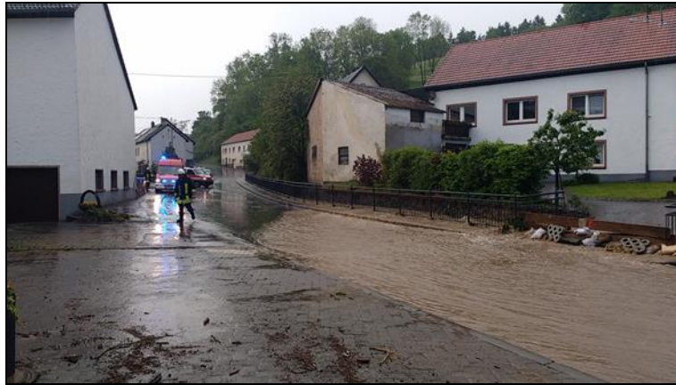
Abbildung 30: Aufstau am Brückenbauwerk Hsnr. 52 am 25.05.2016 (Gerolstein, Freiwillige Feuerwehr, 2016)
