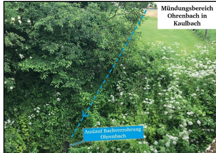
Abbildung 28: Mündungsbereich Bachverrohrung in Kaulbach bei 2. Brückenbauwerk, "Im Überecken"
